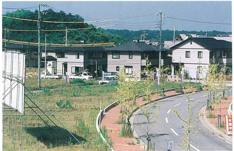
図-4. 建設から2年経過していない新興住宅団地
