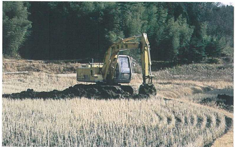
図-2 掘削されている水田
