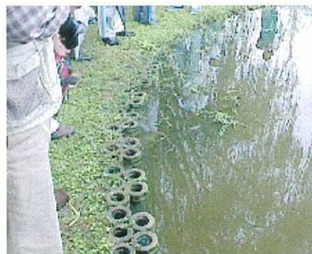
廃品(セラミックフィルタ)を利用した護岸材
