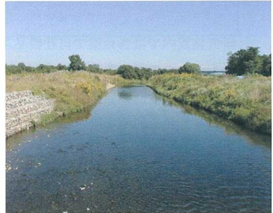
<施設上流側の自然堤防>
